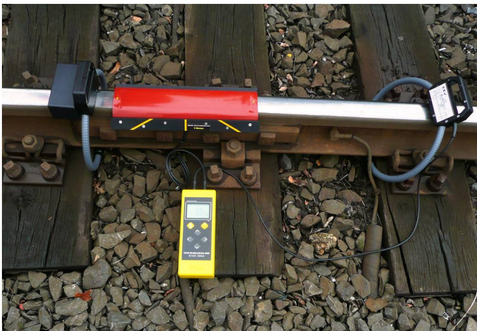
Fig. 3.5 Senseur C disposé derrière le prochain conducteur bifurquant
