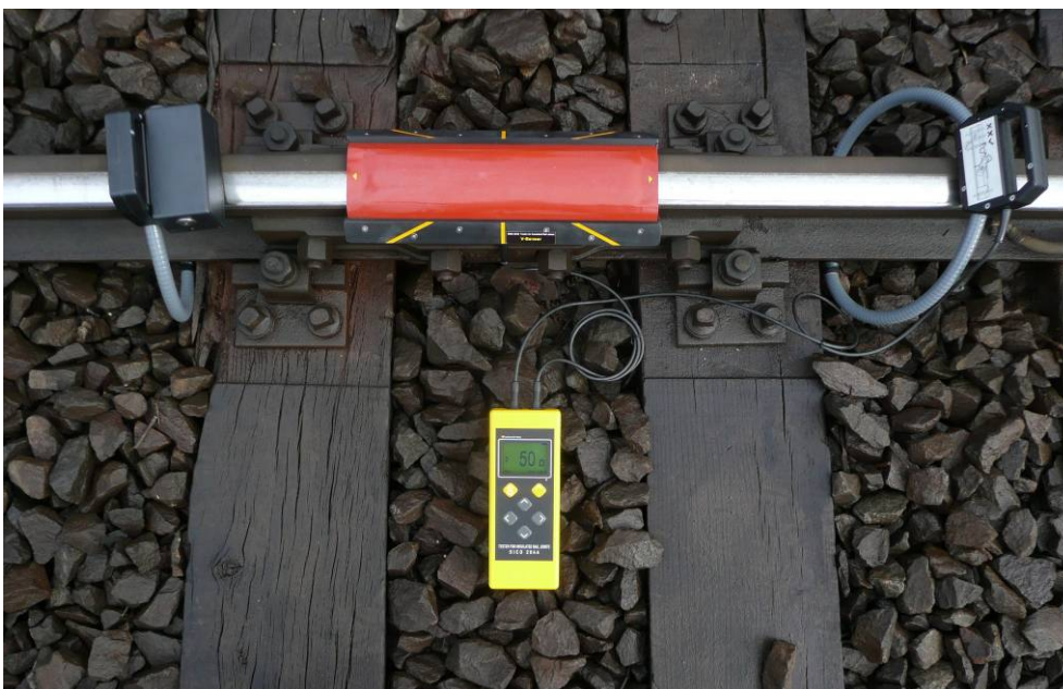
Fig. 3.9 Senseur C disposé derrière la traverse
